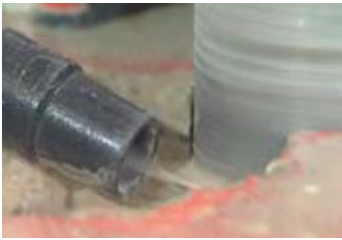
Absaugen des Bohrschlamm
